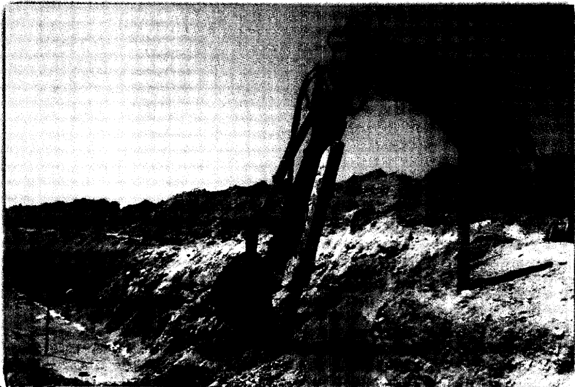
EXCAVACION DE LA BSE DEL TRAMO 03 CON RETROEXCAVADORA
