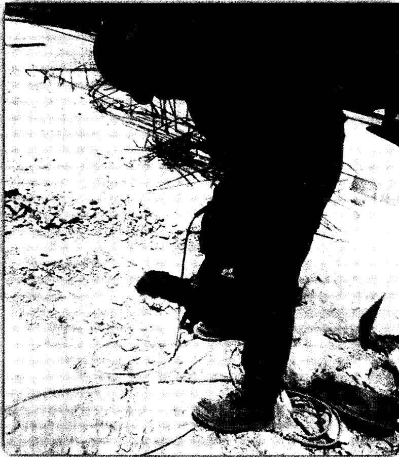
PERFORACION CON ROTOMARTILLO PARA LA COLUMNA TRAMO 02
