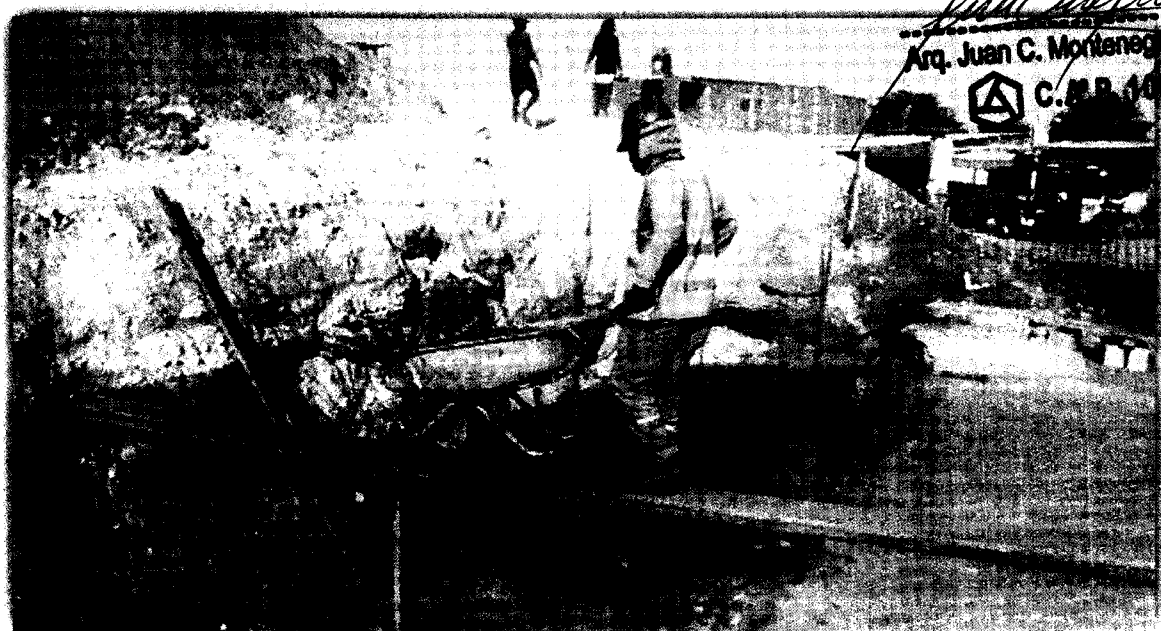
VACEADO DEL CONCRETO PARA LA BASE DEL TRAMO 03
