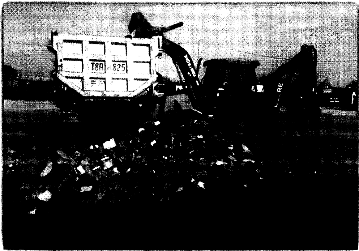
RETIRO DE DESMONTE CON RETROEXCAVADORA Y TOLVA
