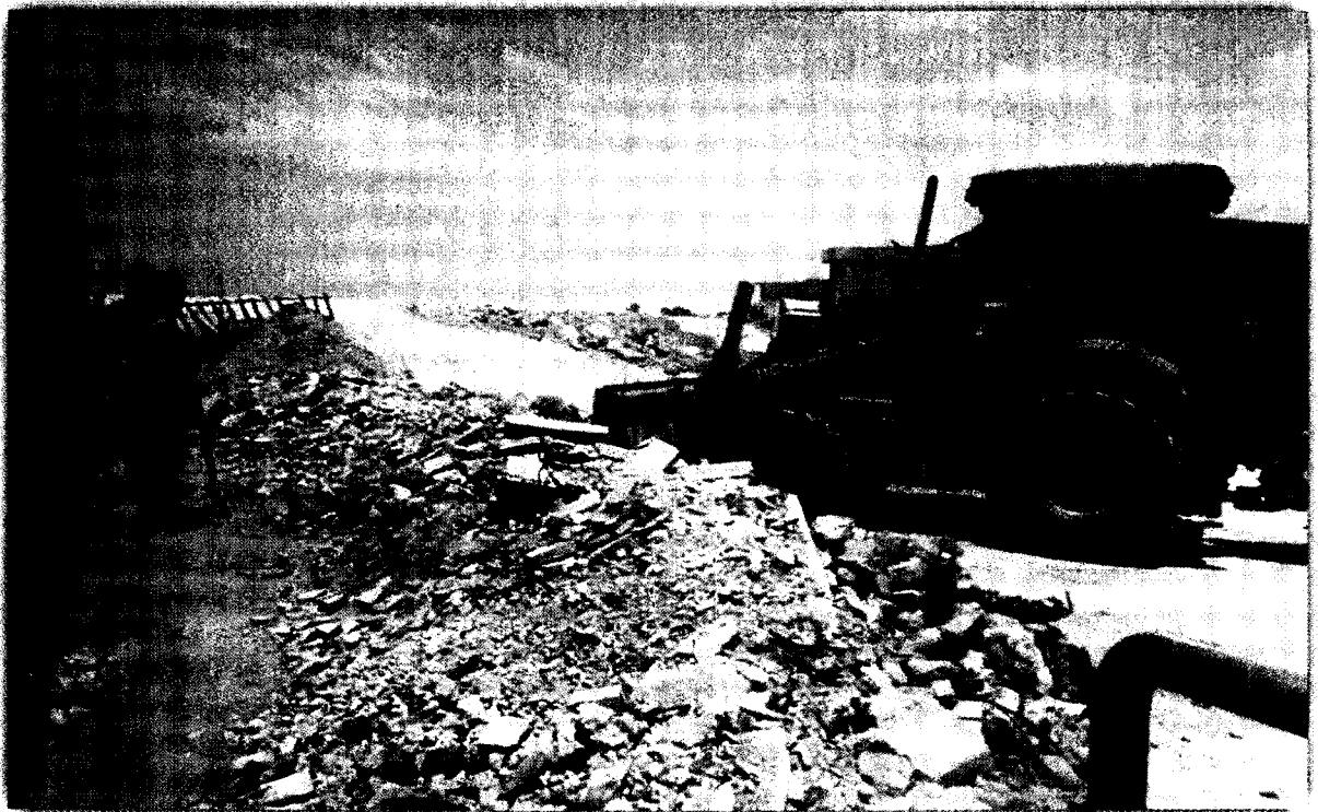
RETIRO DE DESMONTE CON RETROEXCAVADORA Y TOLVA TRAMO 01
